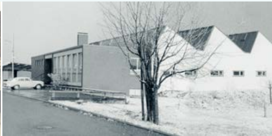
Neubau 1963 in Großheppach im Remstal
